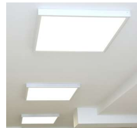
Lắp đặt ốp nổi
